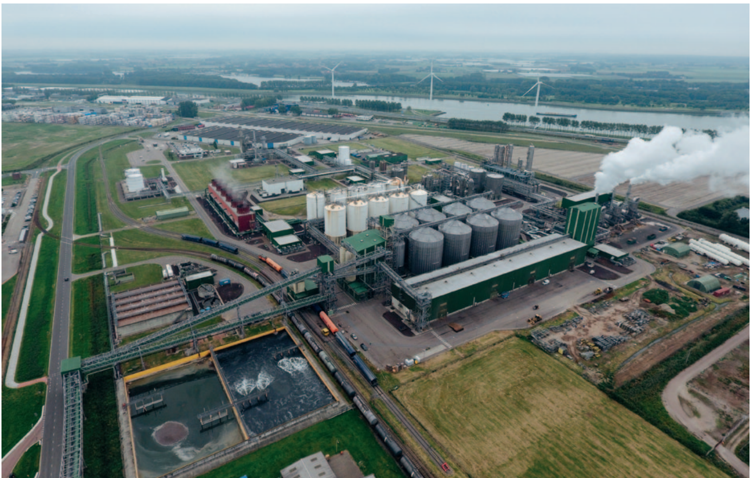
Alco Energy Rotterdam verwerkt jaarlijks 1,15 miljoen ton non-gmo mais tot 480.000 m 3 bio-ethanol, 360.000 ton DDGS en 300.000 ton CO 2 .
